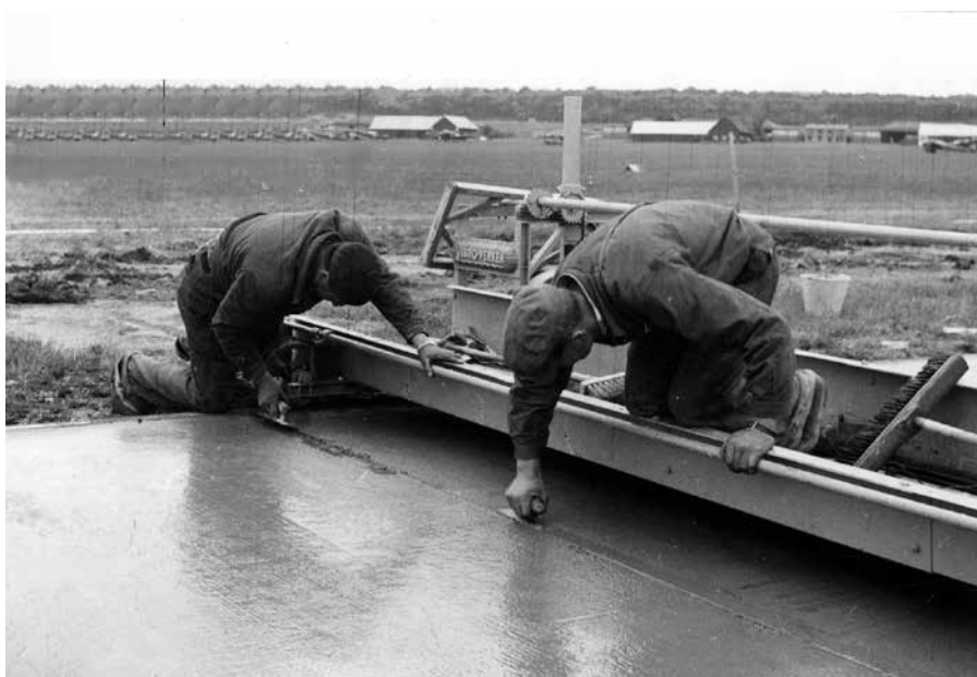
Betongbana 01-19 anläggs 1951 inför övergången till reaflyg.
