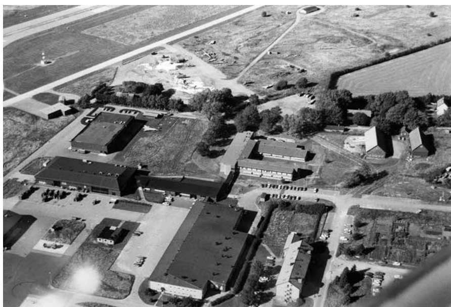
Flygvapnets Markteletekniska skola, sedermera IT-Skolan (mitt i bilden), flyttade in i nybyggda lokaler på 1980-talet. Foto: Tom Manhof.
