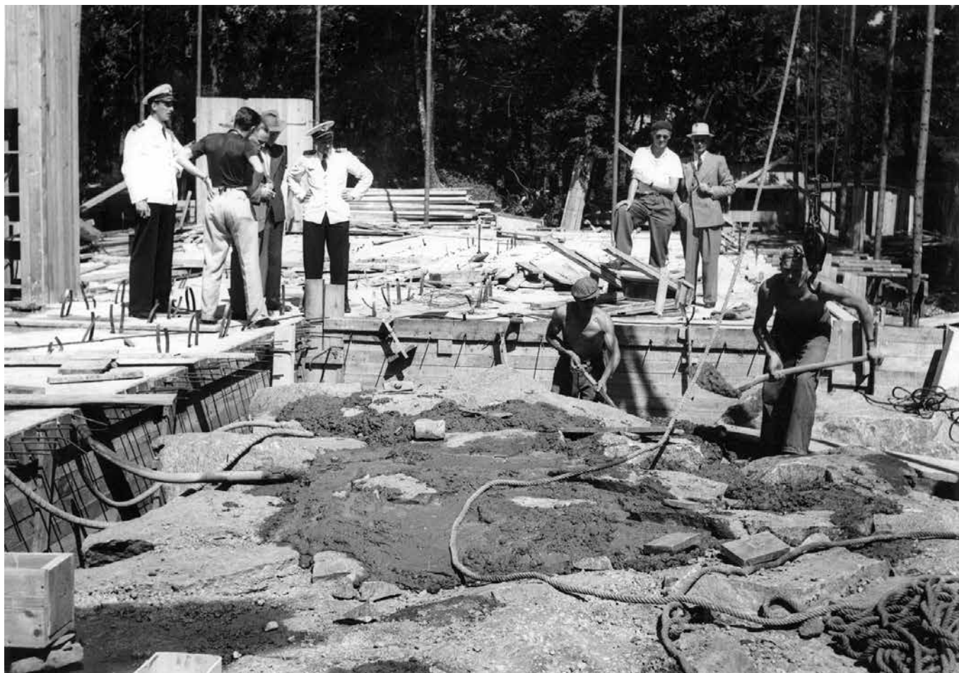
En bottenplatta gjuts. Pressen bjuds på rundtur för att se hur flottiljområdet tar form.
